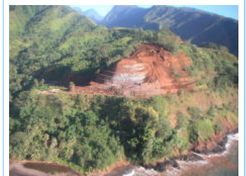
Terrassements à Faaoe
