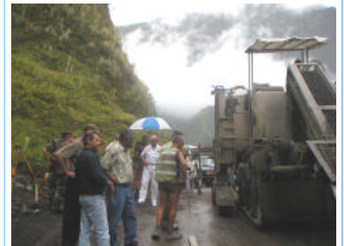
Réunion de chantier de la route traversière de la vallée de Papenoo.
